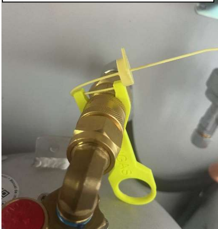
Bild 8 Ventil mit montierter Kupplung und Betätigungsschutz mit Plombe
